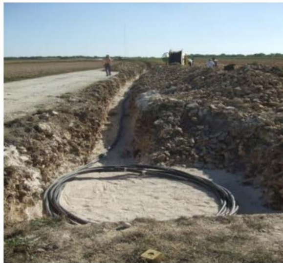
Pose de réseaux HTA
