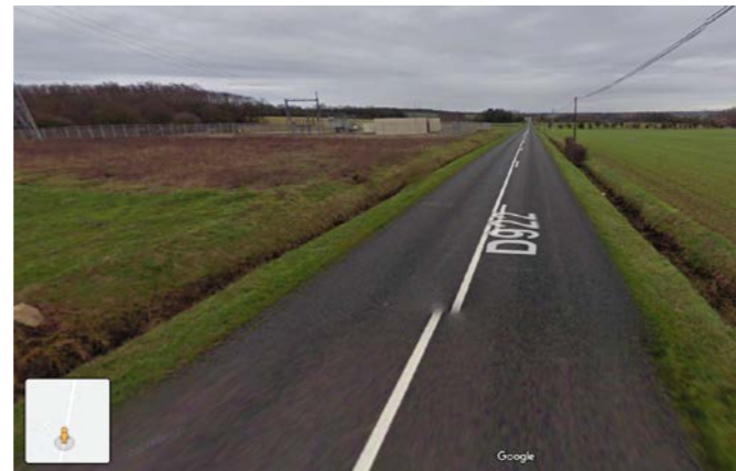
Arrivée sur le poste source de Reboursin (RD922)
